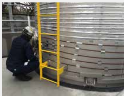
タンクへの自己制御ヒーター施工状況
